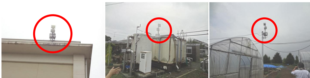
図9・10・11： 校舎・農場内に設置された中継所（丸で囲ったもの）
