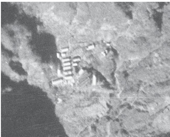
写真2 長尾地区立山炭坑建物全景 米軍(国土地理院)撮影の空中写真(1947年撮影) 写真番号225を拡大
