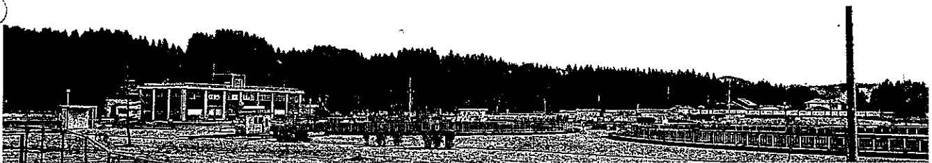
県和田川水道管理所（高岡市島新）
