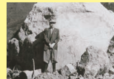
1961 (昭和36) 年、立山砂防を視察に訪れた正雄 (国土交通省北陸地方整備局立山砂防事務所提供)
