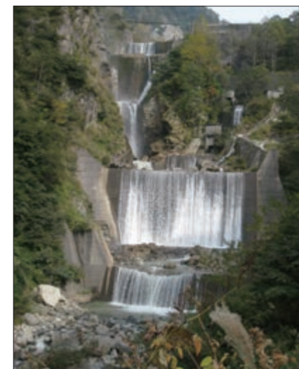
白岩砂防えん堤 (国土交通省北陸地方整備局立山砂防事務所提供)
