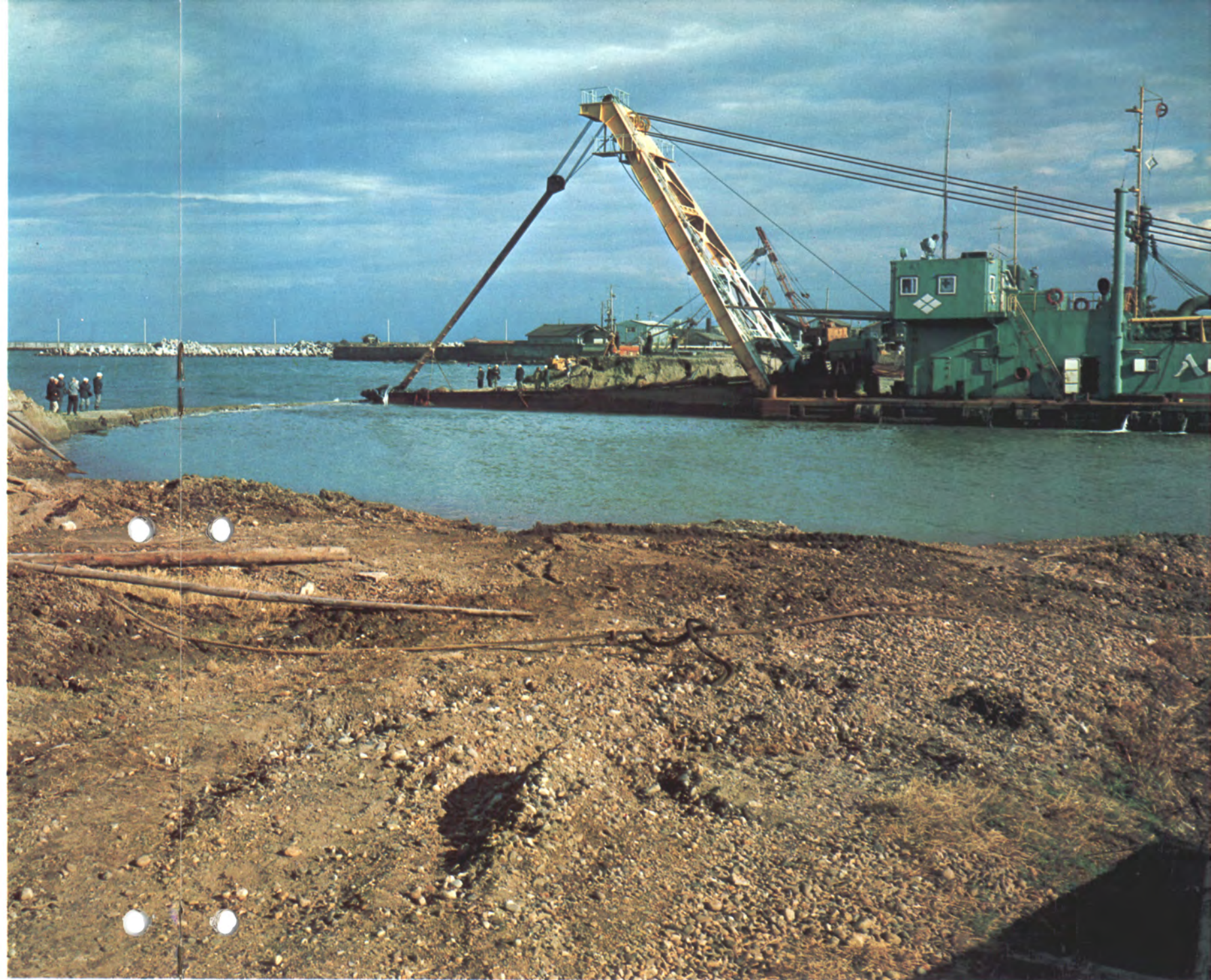
急ピッチで作業を続ける、富山新港の港口本切断
