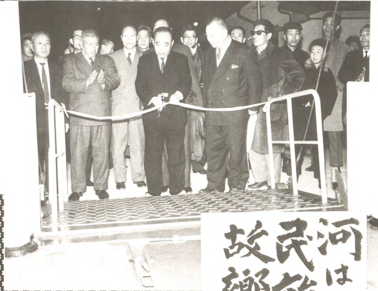
富山新港の港ロ本切断による、フェリーポート就航のテープカットをする吉田富山県知事
