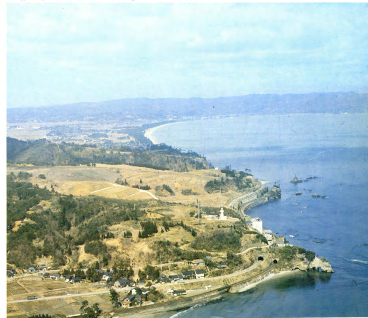
高岡市伏木岩崎鼻から氷見海岸を望む
