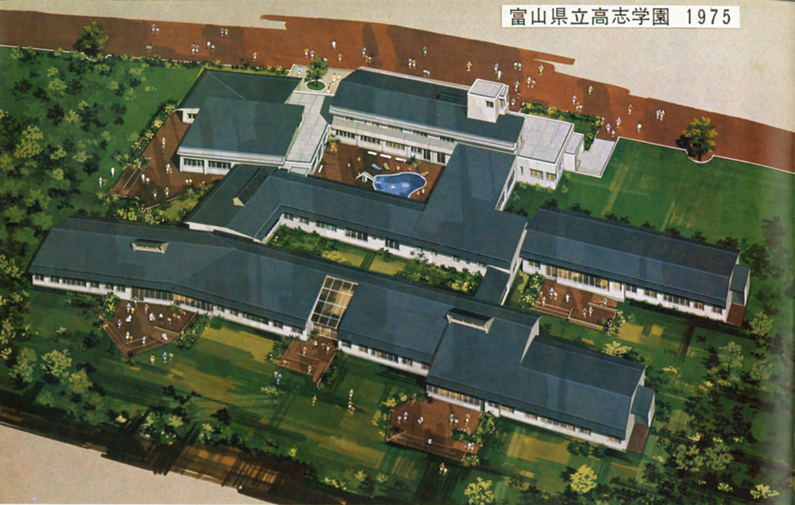
富山県社会福祉総合センターの建設は まず肢体不自由児施設高志学園の改築から
