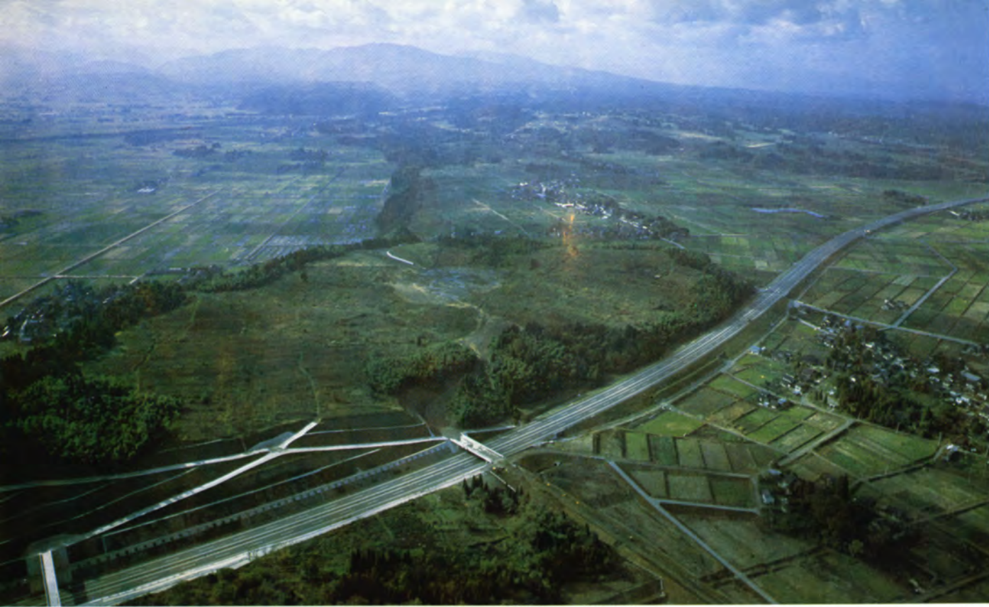
昭和54年度の大学校舎建設完成をめぐり整備を急ぐ富山市杉谷の敷地
