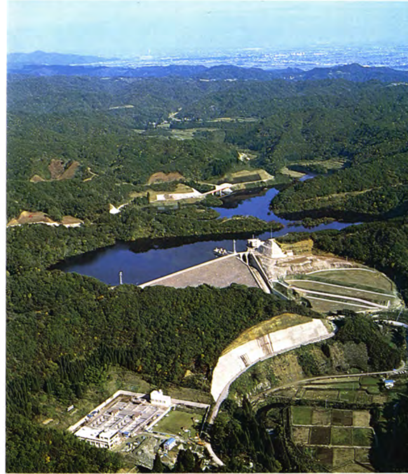
高岡・小矢部市への上水道をはじめ多目的ダム—子撫川ダムは満水—
