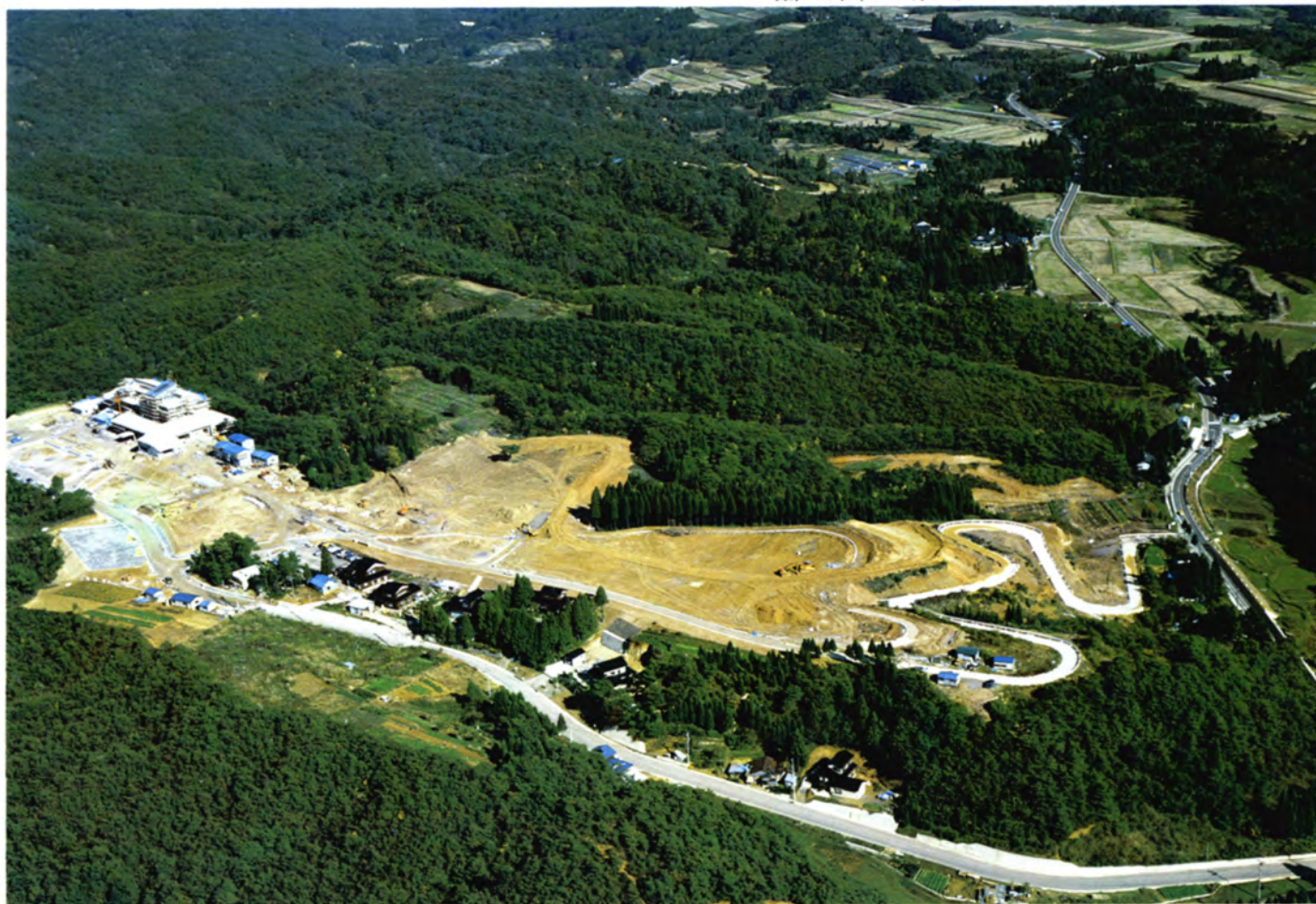
婦中町細谷地内に建設中の勤労者いこいの村（53年10月30日空撮）は今年の5月にオープン ☎(07646)5-5770
