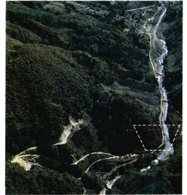
治水 上水道など多目的な熊野川ダムは57年完成予定
