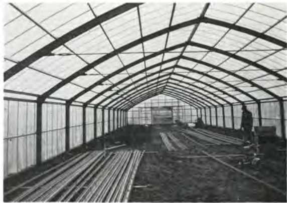
1棟3アールの大型ハウスの建設進む福野町のハウス団地
