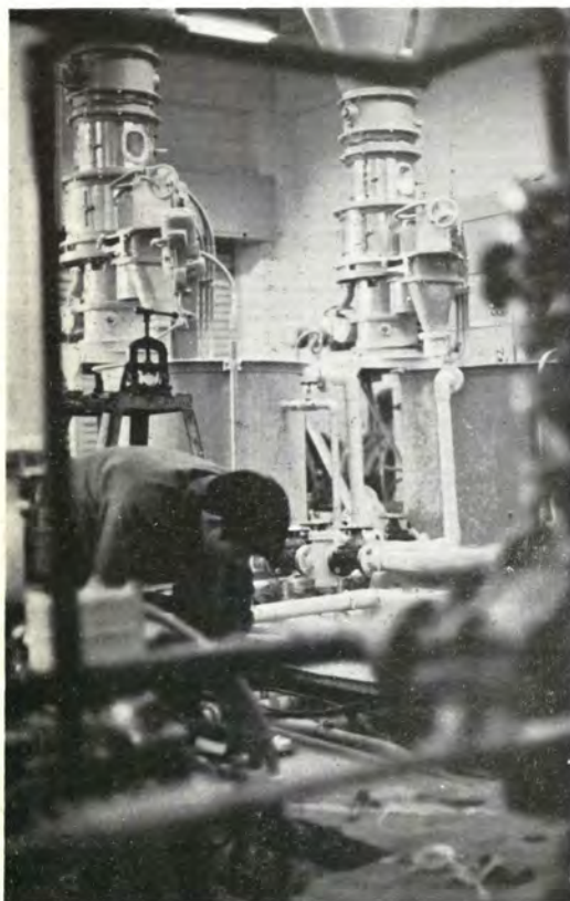
▲ 高速沈澱用の薬品注入装置
