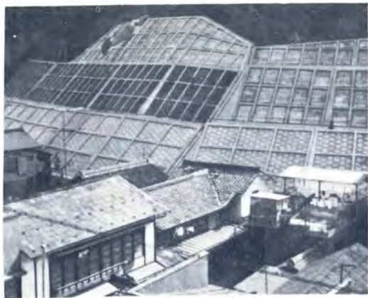
工事が完成し安全になった急傾斜地
