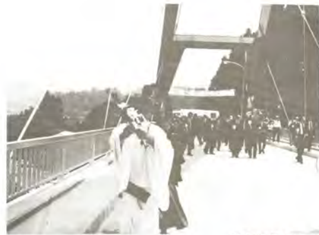
愛本橋竣工する
