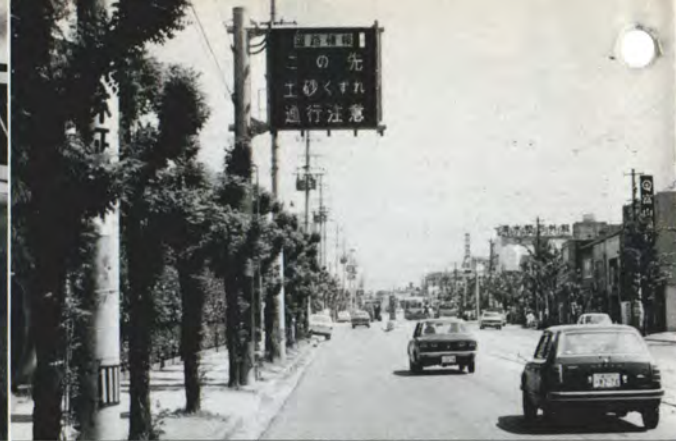
事故や異常気象による道路状況の変化をいち早くドライバーに知らせる道路情報板山沿いの道路に多く設置されている
