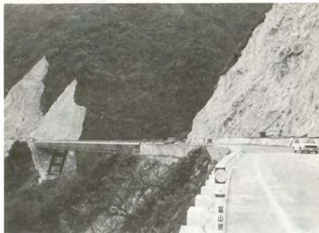
完工した駈足谷橋
