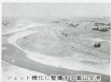
ジェット機化に整備する富山空港
