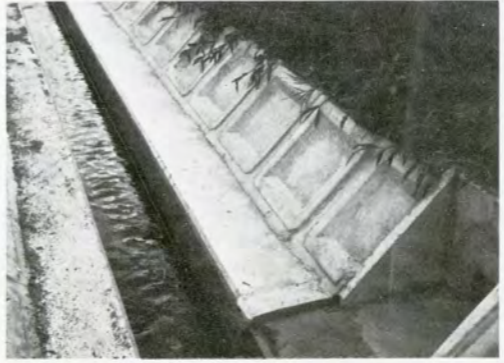
▲張ブロック工事
