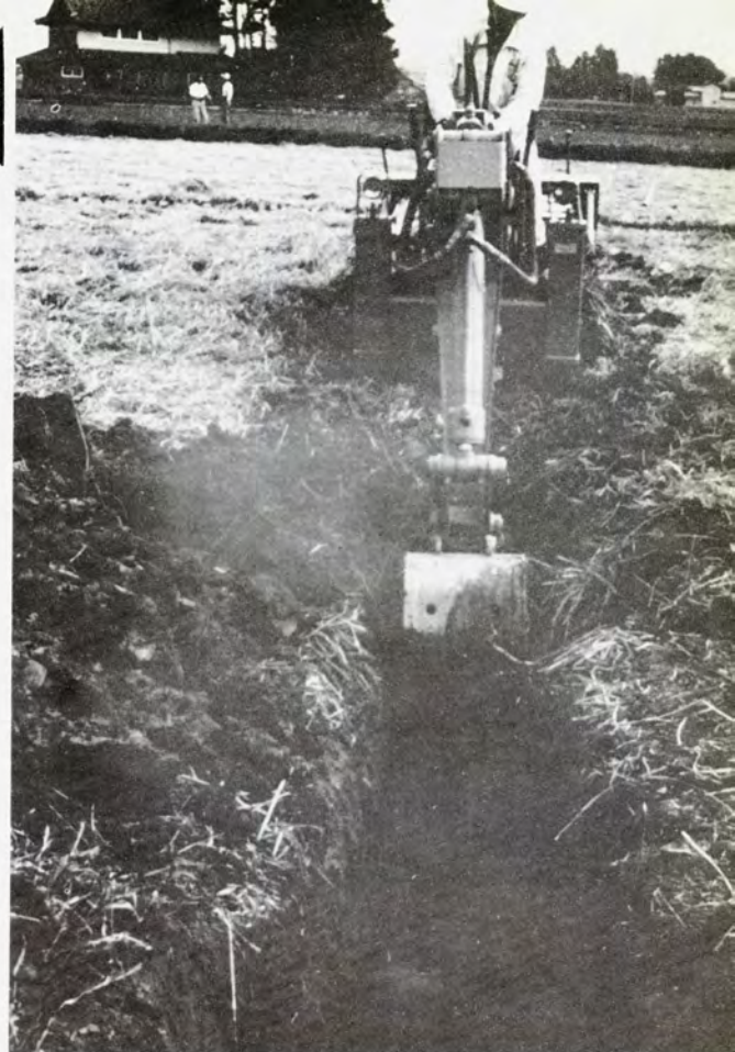
①バケットを利用して溝掘りをする
