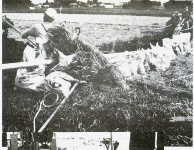
③吸水管の敷設
