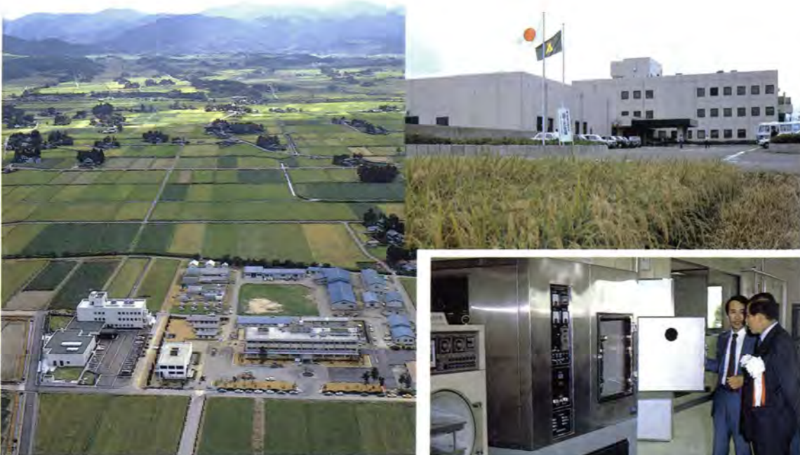
▲農業試験場のとなりに完成した食品研究所
