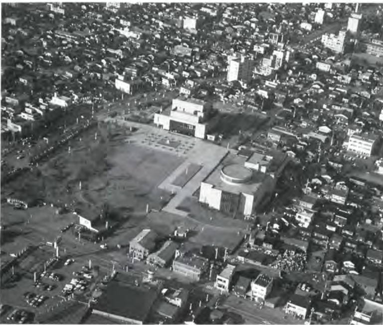
気軽に利用できる施設を整備しています
