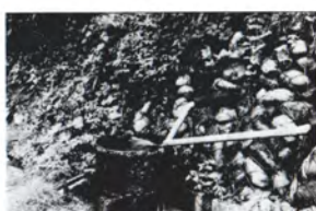
横ボーリング工：ここから地下水を抜きます。
