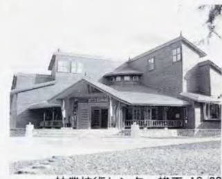
林業技術センター竣工 10/30
