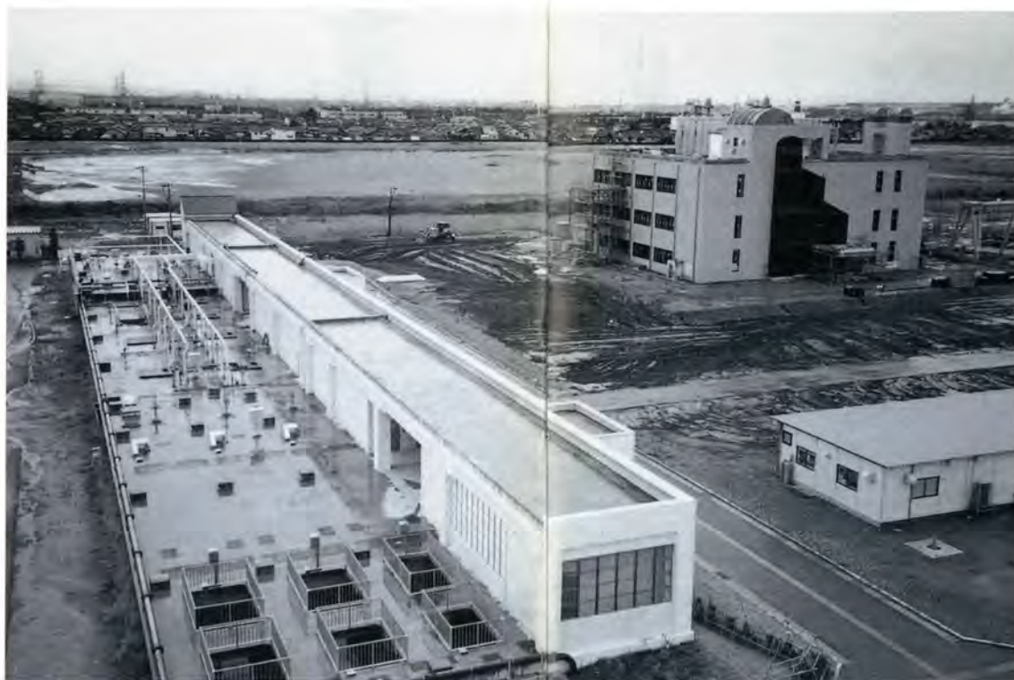
▲神通川流域下水道の水処理施設(左)と管理ポンプ棟(右上)
