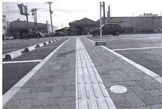
公道まで延びる誘導ブロック
