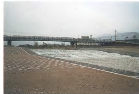
川幅の拡幅と床止め工で安全性を高めた小矢部川(福光町)
