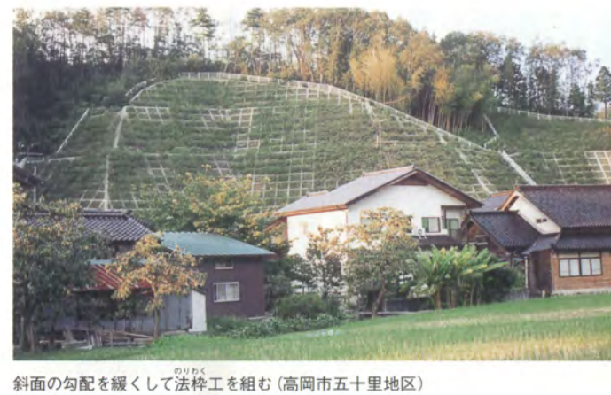
斜面の勾配を緩くして法砕工を組む（高岡市五十里地区）
