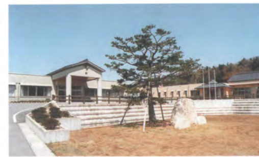
5つの施設に再編整備され改築が完了したセーナー苑
