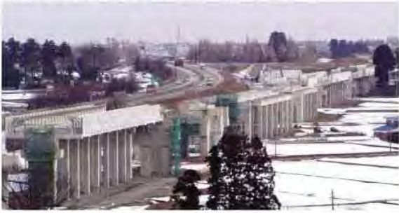
北陸新幹線建設工事が進む新黒部駅(仮称)周辺の様子
