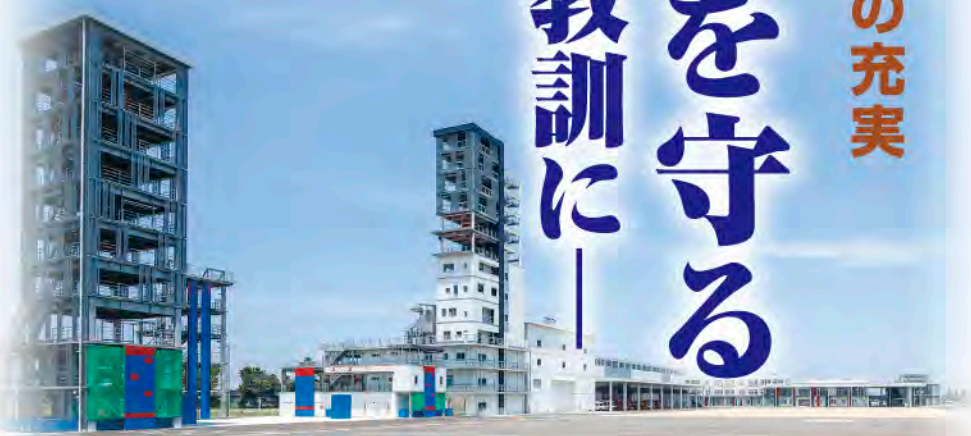
富山県広域消防防災センター(富山市惣在寺1090-1) 全国トップレベルの訓練施設と体験型の学習施設を兼ね備えた総合的な防災拠点施設。災害時には、災害対策の活動拠点となる。
