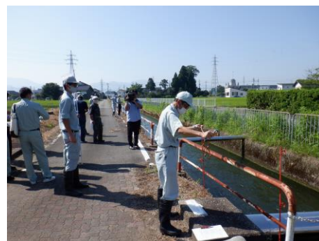
応急処置 虎ロープ設置（高さ対策）
