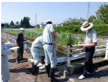
応急処置 チェーン柵設置（隙間対策）
