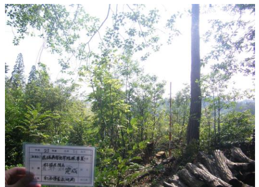
道路沿線にある枯損木を除去しました
