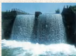
▲共通幹線水路 大落差工 (落差約12m 立山町横江野開)
