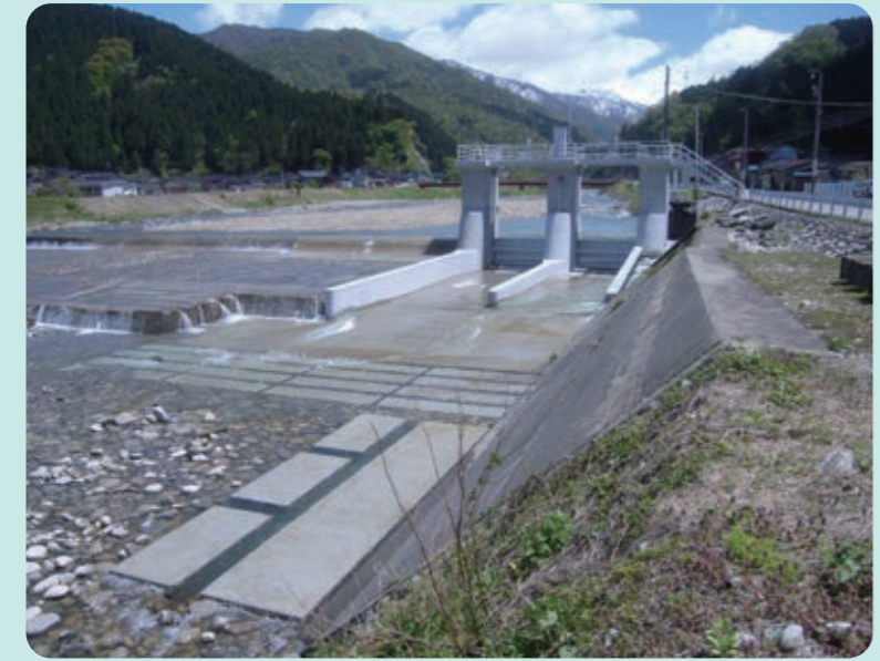
整備が進められている小川頭首工
