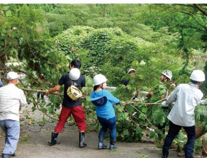
▲倒木撤去作業
