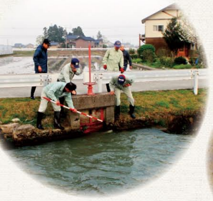
水路施設の 点検
