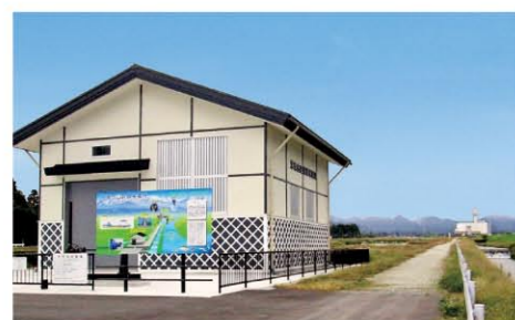
▲常東合口幹線発電所 (最大出力 528kw)
