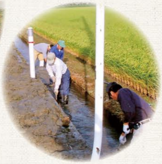
水路の 泥上げ
