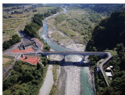
▲左岸連絡水路橋
