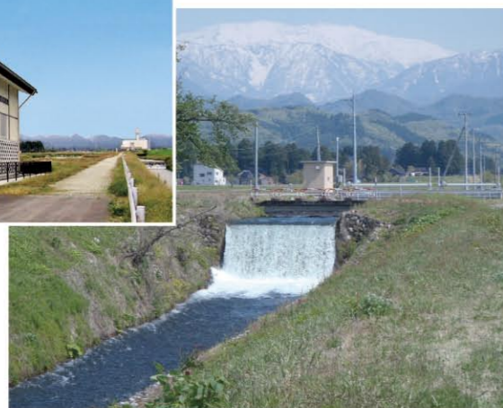
▲常東合口用水路 大落差工
