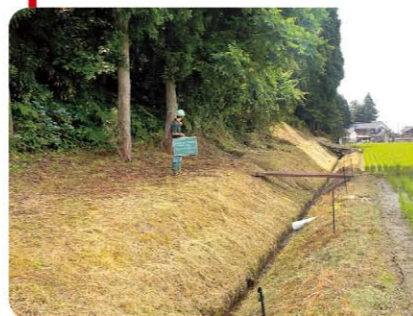
▲緩衝帯の整備(魚津市)
