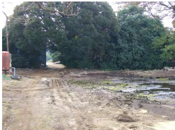
図2 汚染源の例(冠水)
