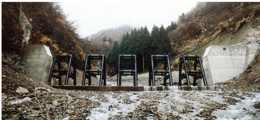
スリット型治山施設 (谷止工) [南砺市 (旧平村)]
