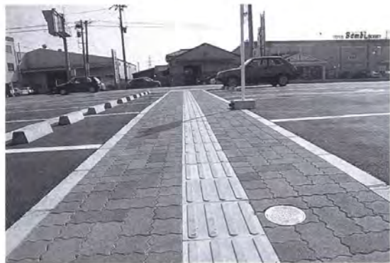
公道まで延びる誘導ブロック
