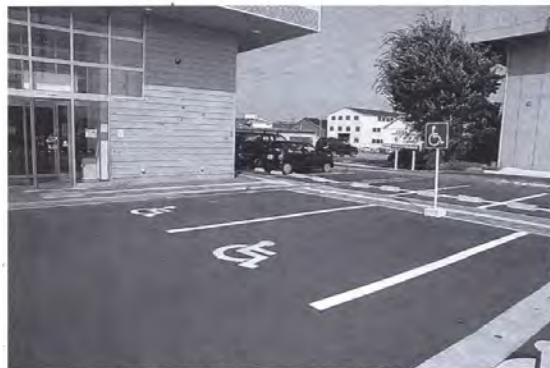
車いす使用者用の駐車スペースも確保されている
