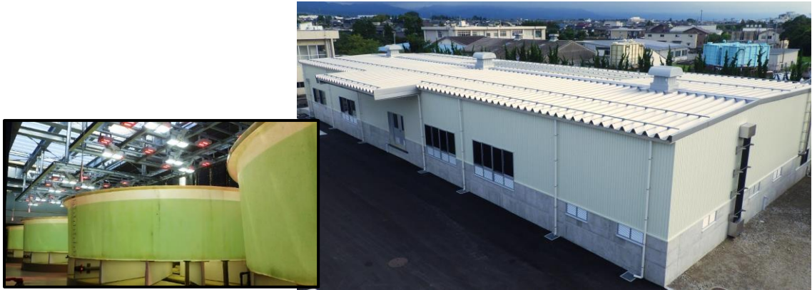
水産研究所のキジハタ・アカムツ種苗生産施設（令和元年8月竣工）
