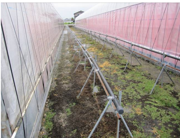
図 融雪装置の設置
