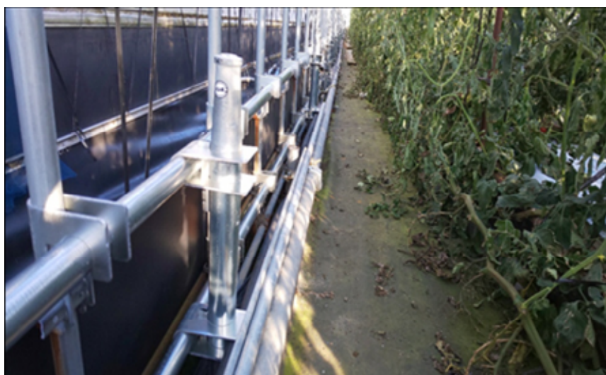
図 ハウスの浮き上がり防止
