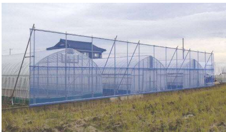
図 防風ネットの設置
