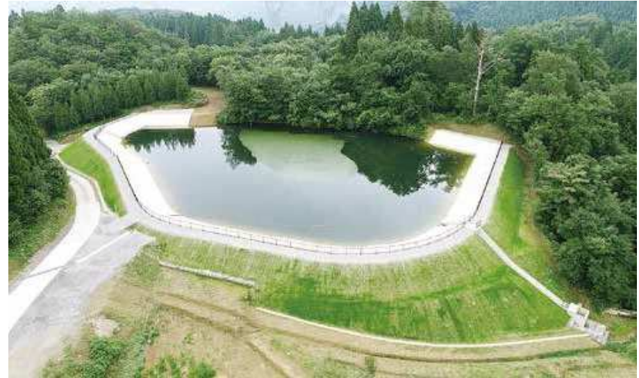
伊藤建設(株)施工の「県営農村地域防災減災事業大菅沼地区大菅沼池堤体改修工事」
