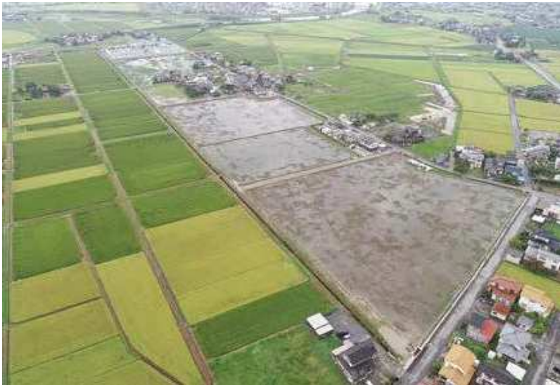
水新建設(株)施工の「ほ場整備水橋石政地区第1工区ほ場整備工事」
