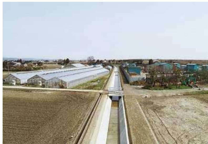
(株)吉田組施工の「基幹水利施設四ヶ村地区四ヶ村用水路第 7 工区工事」
