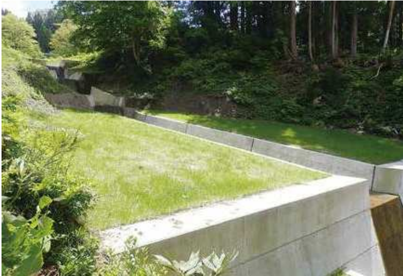
米澤工業(株)施工の「地すべり防止大豆谷地区溪間工事」
