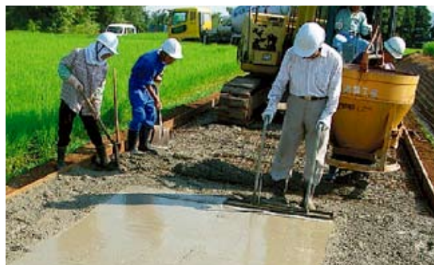
農道のコンクリート舗装
