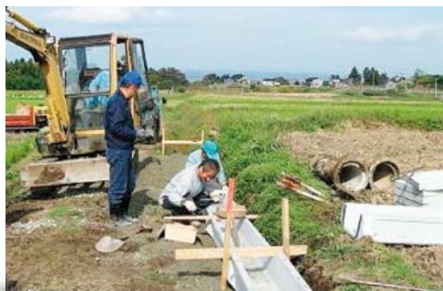
自己施工による用水路の改修 (魚津市下楯集落)
