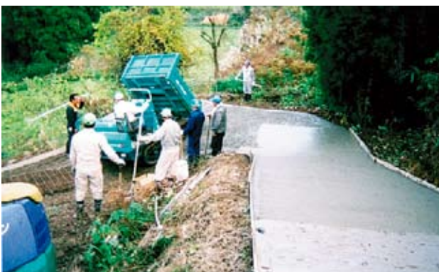
農道舗装作業風景
