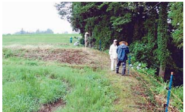
自力施工による電気柵の設置
