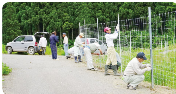
集落での耐雪型侵入防止柵の設置
