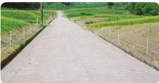
電気柵の設置
