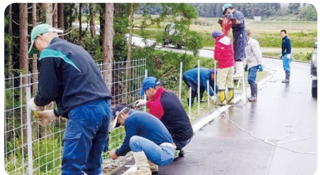
ワイヤーメッシュ柵の設置
