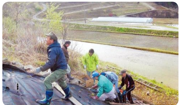
道路法面への景観作物植付状況
