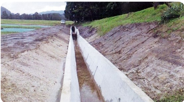
大林用水路の改修箇所
