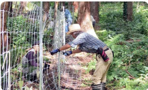
耐雪型侵入防止柵の設置作業
