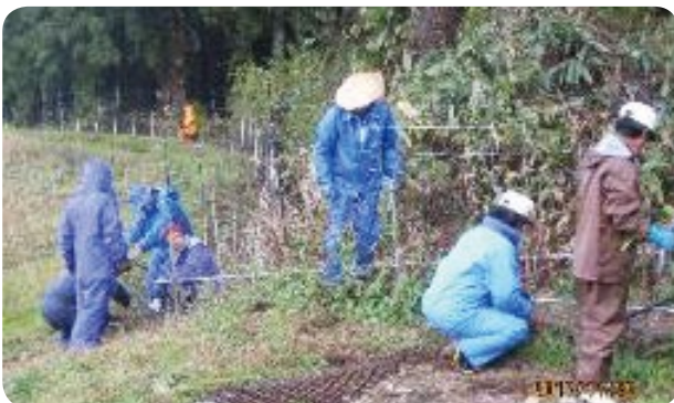
電気柵補強作業
