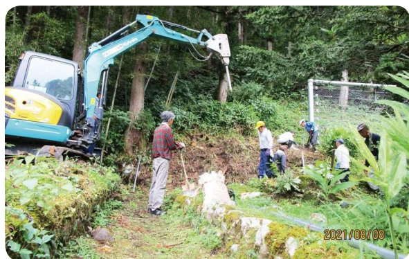
恒久金網柵の設置
