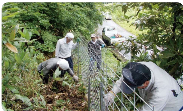
耐雪型侵入防止柵の設置
