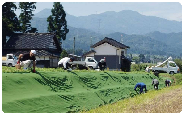
防草ネット張り
