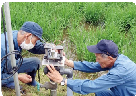
自動給水栓による管理
