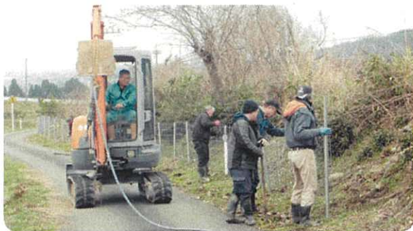
恒久柵の設置
