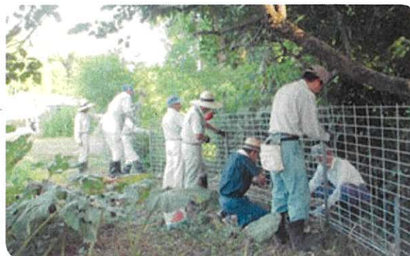
恒久柵の設置
