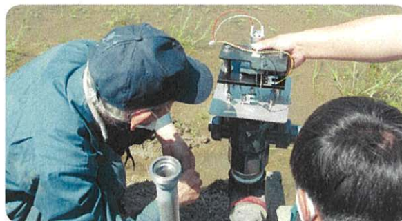
自動給水栓の取付
