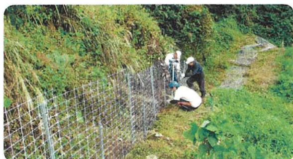
恒久柵の設置
