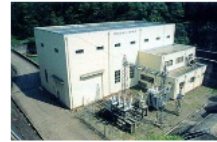
庄東第二発電所
