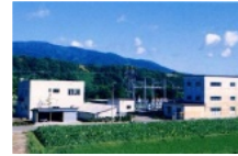
小矢部川第二発電所
