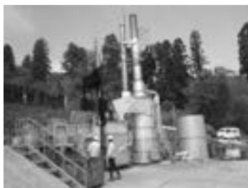
焼却施設の調査
