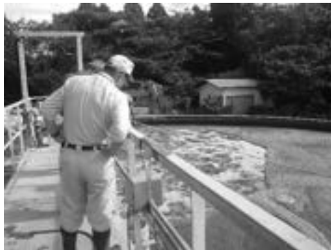
排水処理施設の確認
