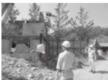
中間処理施設の調査
