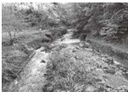
図 2 笹川上流(上笹川橋付近)
