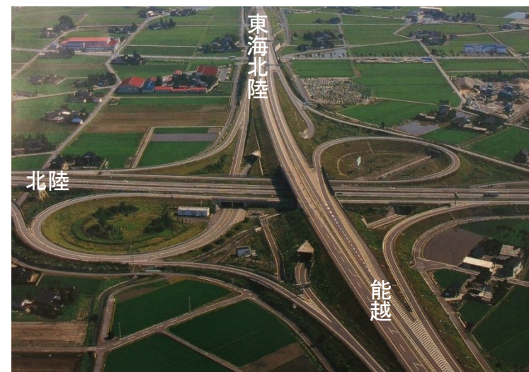
3つの高速道路が交差する小矢部砺波ジャンクション
