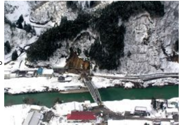
国道156号災害現場
