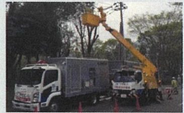
電源車による災害時の復旧作業
