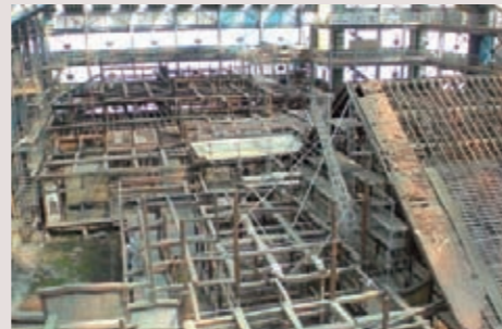
「大広間」「小書院」の解体調査 (写真提供 (公財)文建協)
