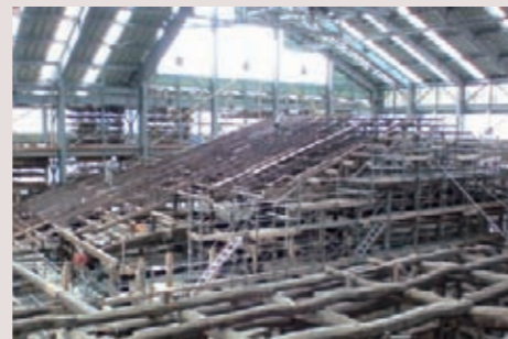
「台所」の軸部組み立て (写真提供 (公財)文建協)
