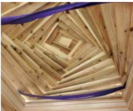
内部から見た屋根構造
