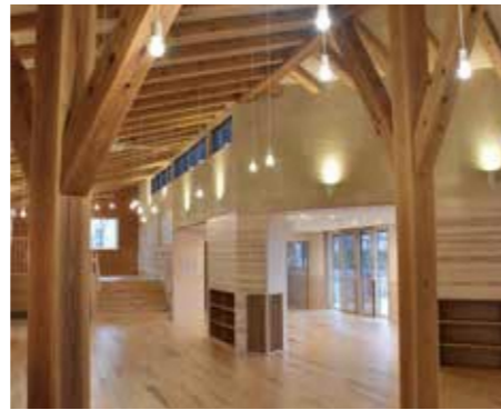
方杖を伸ばした大径材の柱が大屋根を支える
