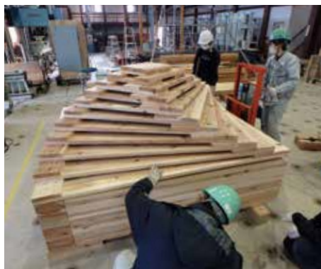
全体の組上げ作業の様子
