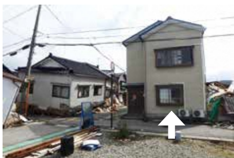
写真① 倒壊を逃れた、開口部が少なく耐震要素の多い住宅
