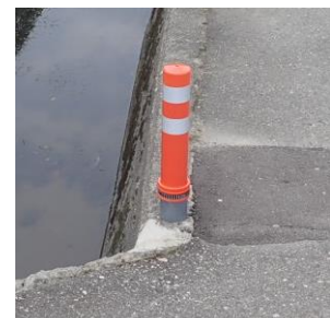
ポールコーンによる視認性向上
