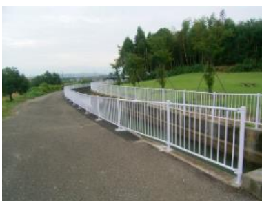
転落防止柵の設置
