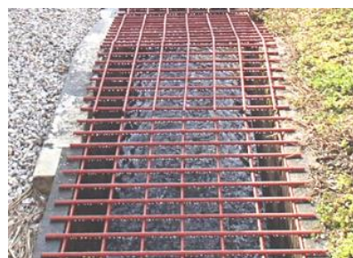
転落防止網の設置
