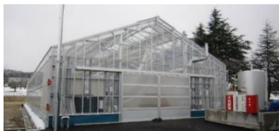
ミニトマト(1棟)、イチゴ(1棟)を設置
